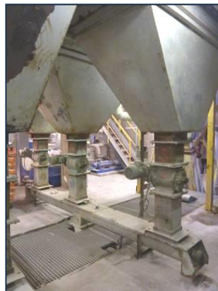
A droite: Vue de la partie basse de la chaudière où sont extraites des cendres volantes
